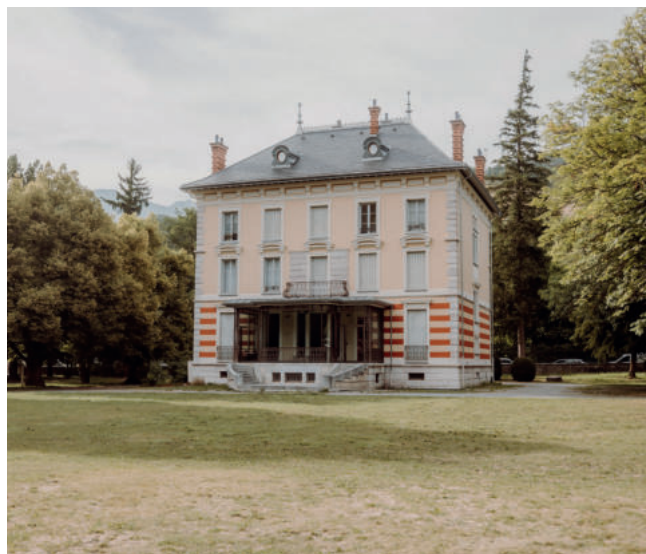
La Villa La Sapinière à Barcelonnette.
