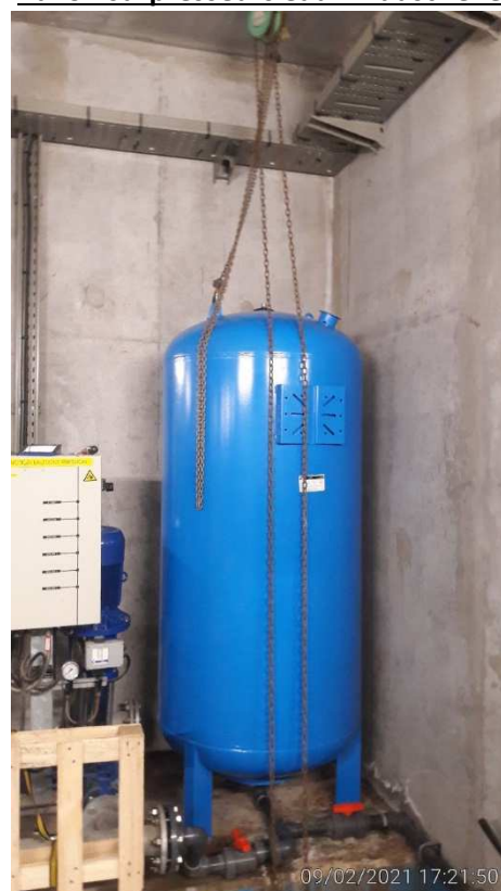
Ballon surpresseurs eaux industrielles
