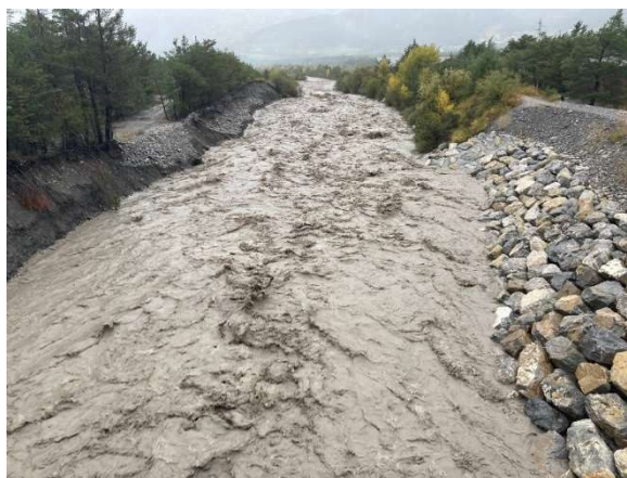
↑ Figure 4 - Le Bachelard au niveau de Pont Rouge vue aval vendredi à la mi-journée
