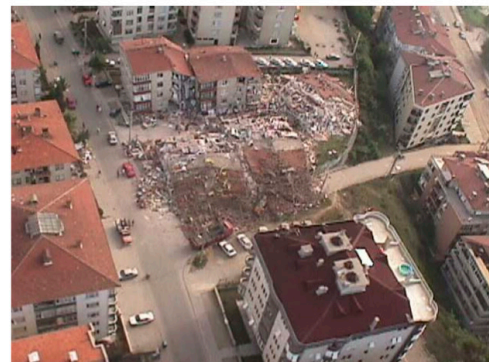
Séisme d'Izmit (Turquie 1999). De nombreux exemples ont montré sur des groupes de structures a priori identiques, des différences de dommages considérables.
