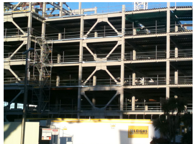
Exemple de dispositif de renforcement parasismique. Des dissipateurs ductiles encaissent la déformation latérale, Christchurch 2011
