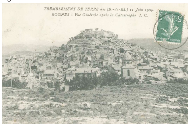
Exemple d'effet dû au relief : la ville de Rognes, construite sur un relief marqué, présenta des dommages plus importants en son sommet lors du tremblement de terre de Lambesc 1909.
